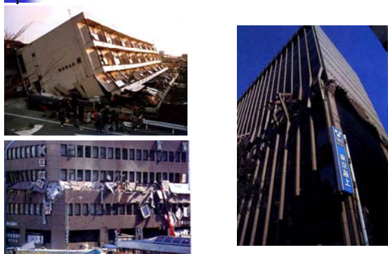
上 倒壊したマンション(西宮市安井町) 上 5階が層崩壊したビル 下 3階が層破壊したビル(神戸市中央区) (神戸市中央区)
